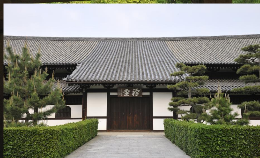
重要文化財 東福寺大禅堂
